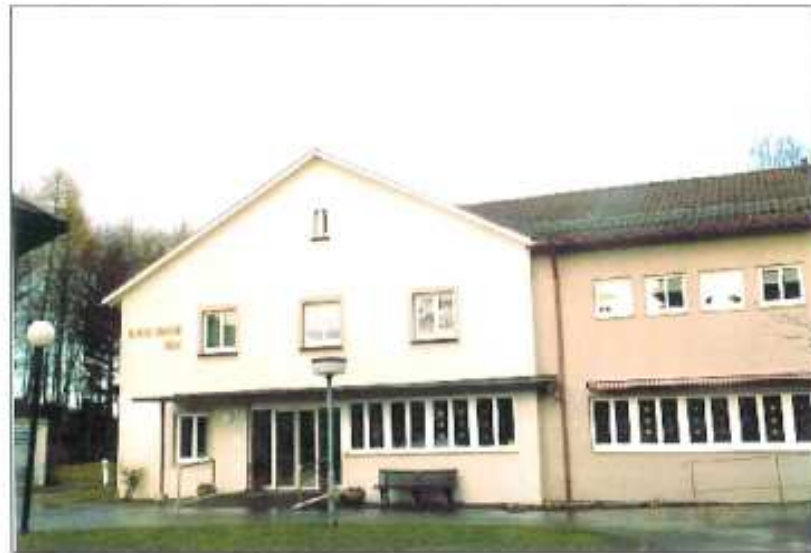
Ansicht Westseite, Eingangsbereich
