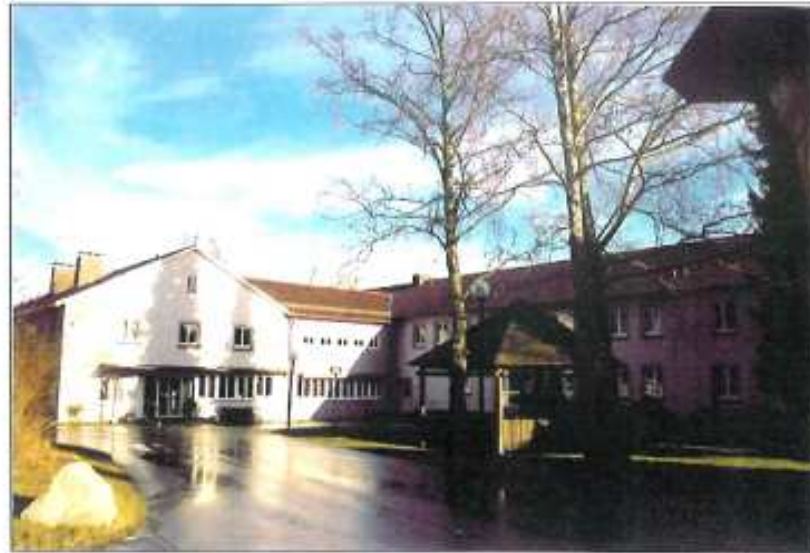
Ansicht Westseite, Zufahrt
